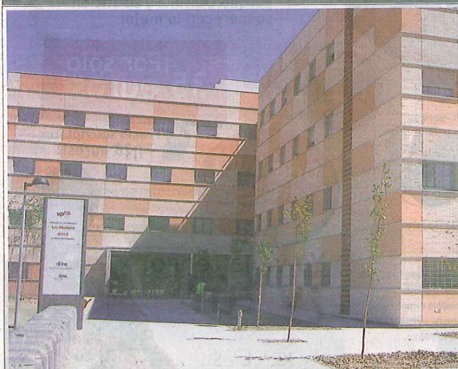
Imagen exterior de las instalaciones, situadas en Arrosadía, en donde se ultiman estos días los detalles. EGUARAS
